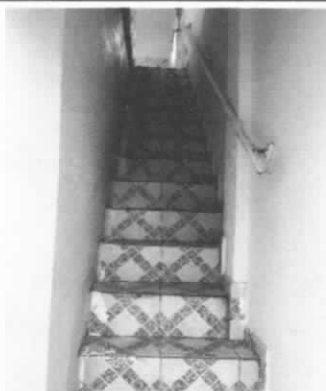
FOTO 03 - ESCADA DE ACESSO AO PAVIMENTO SUPERIOR
